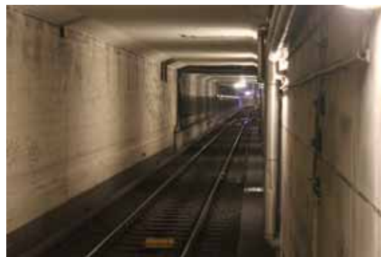
Blick in die Tunnelröhre Richtung MV
