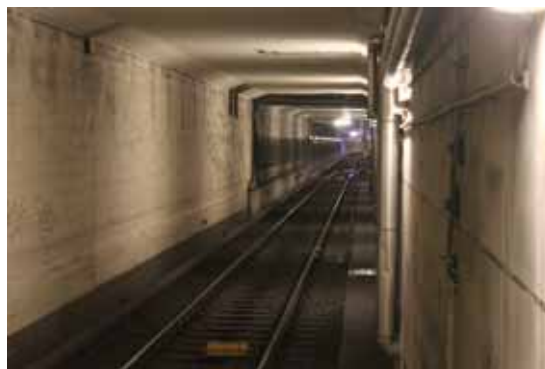
Blick in die Tunnelröhre Richtung MV
