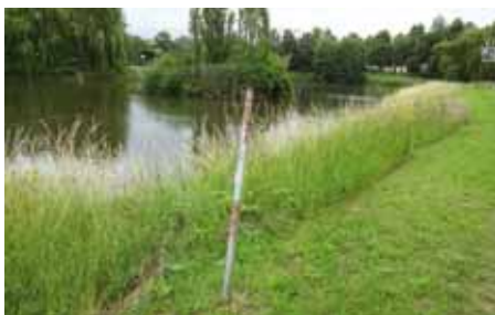
Fehlende Rettungshilfen am Mittelfeldbecken
