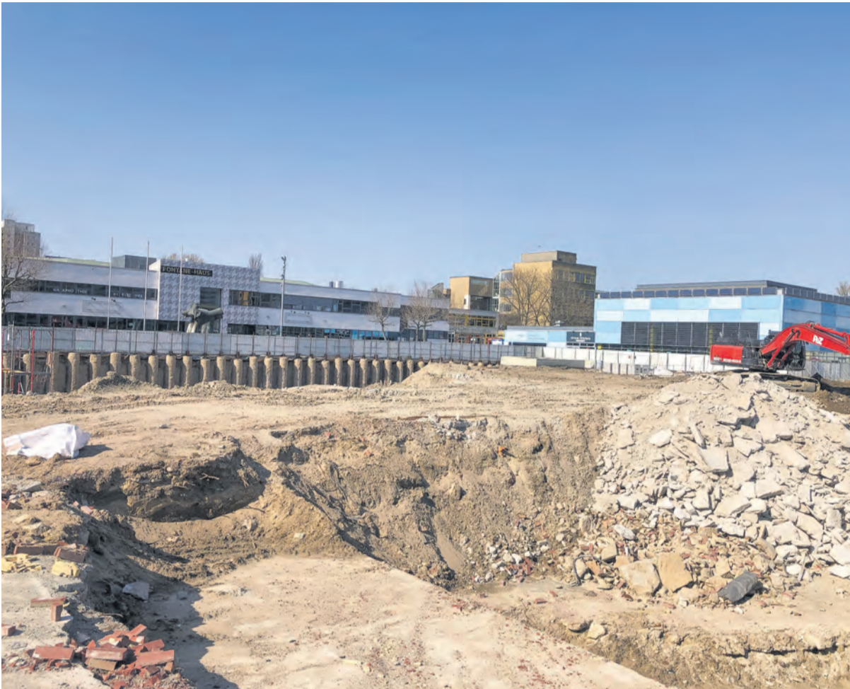
Zu lange Stillstand nach dem Abriss – Weiterbau zum Jahreswechsel?
